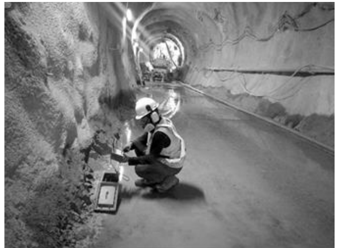
Figura 11: Instalación y verificación de parámetros de un sismógrafo antes de la ejecución de la voladura.
